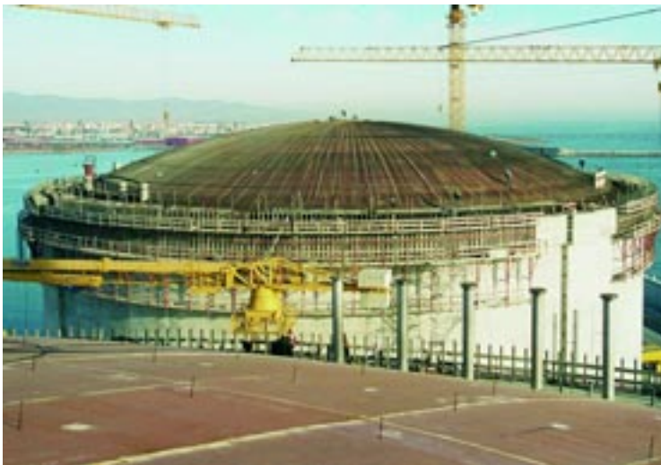
LNG Tanks, Sagunto, Spain
