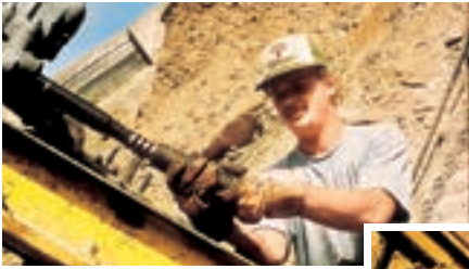
Aufschrauben der Bohrkron
