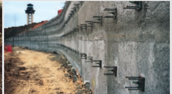
Mit DYWIDAG-Bodennägeln gesicherte Stützwände
