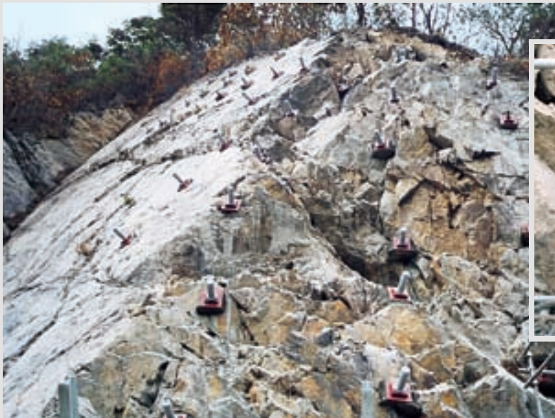
Mit DYWIDAG-Stabankern gesicherter Hang
