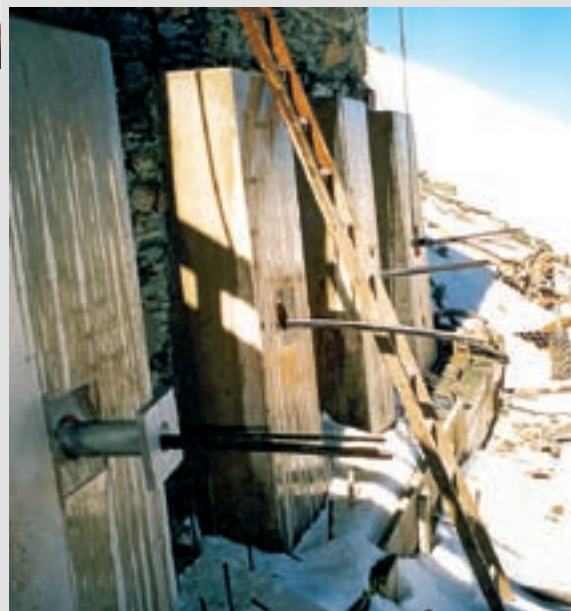
DYWIDAG-Litzenanker nach Einbau
