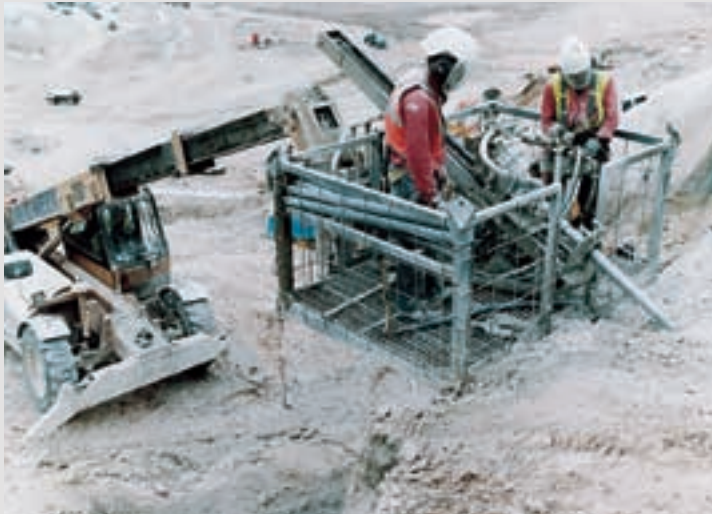
Montagearbeiten in den höheren Hangregionen auf Bohrplattformen
