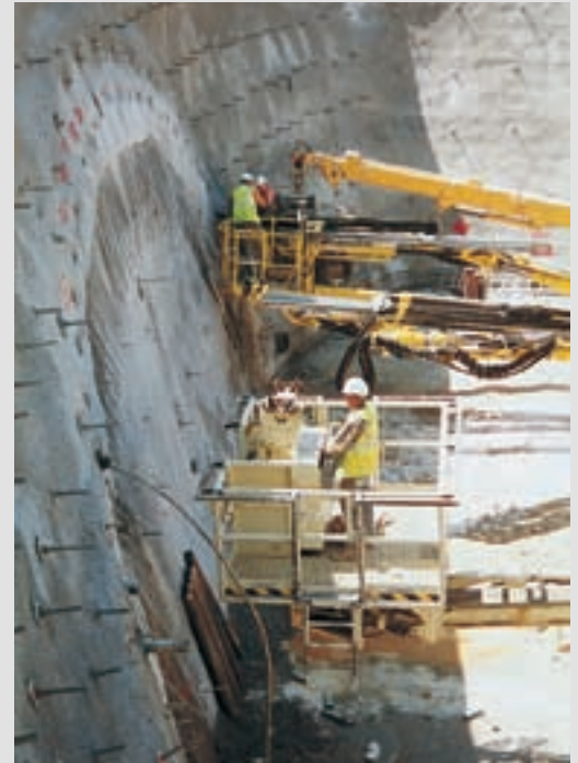
Zur Montage in den höheren Hangregionen wurden die Bohrplattformen an Teleskoparme befestigt.
