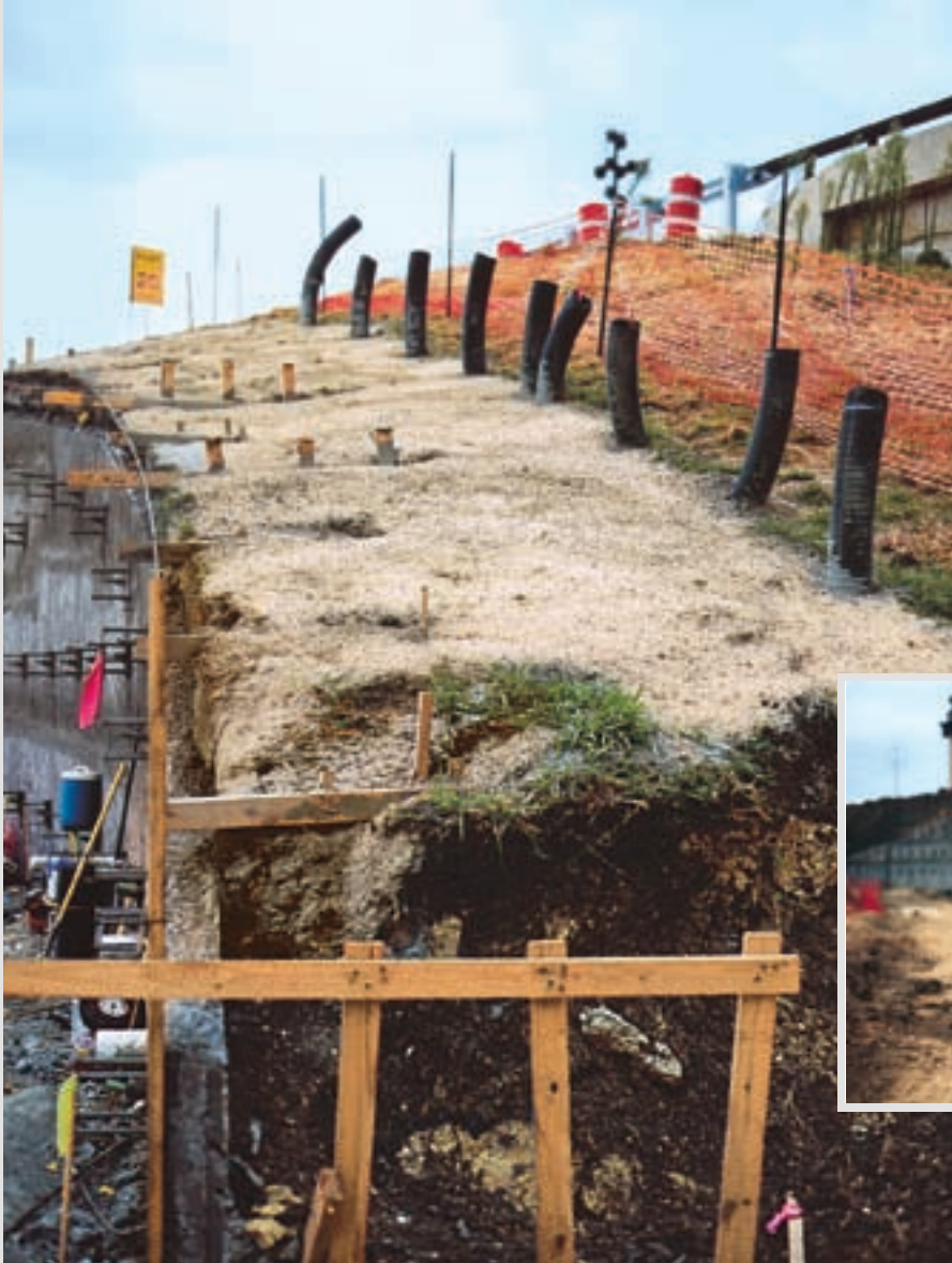
Mit DYWIDAG-Bodennägeln gesicherte Stützwände
