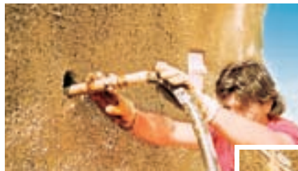
Injektion durch den Hohlstab
