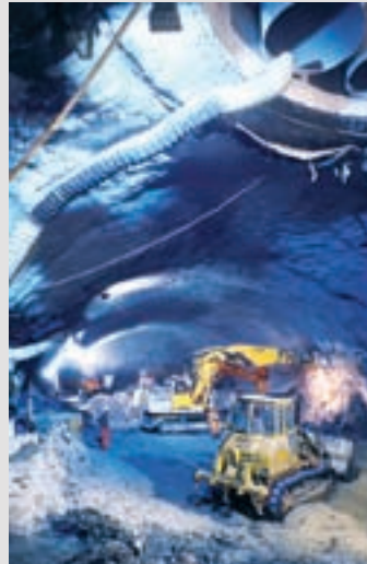
Ausbrucharbeiten in der Kaverne
