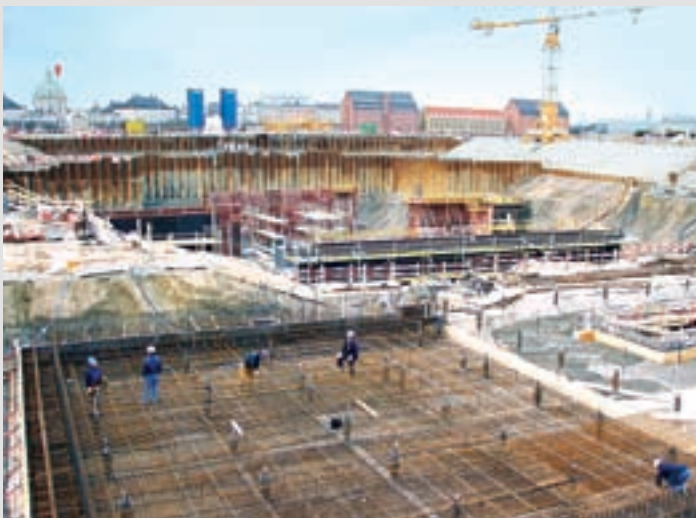
Der Bauort befindet sich auf gleicher Höhe mit der Marble-Kirche und dem Schloss Amalienborg
