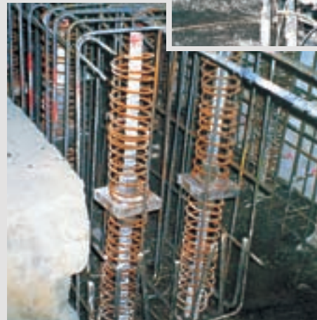
Detailansicht eines GEWI®-Pfahlkopfes (Druck/Zug)
