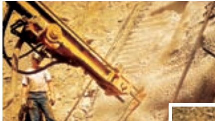
Bohren mit der Ankerstange
