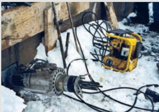
Spannen der DYWIDAG-Litzenanker
