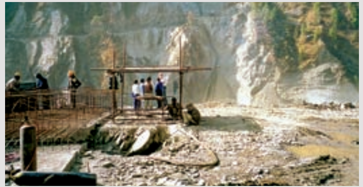
Lage der Betonstaumauer mit Fundament für Kabelkräne
