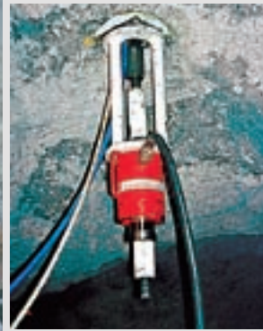
Kleines Bild: Spannen mit lokalen Spannpressen über Spannstuhl
