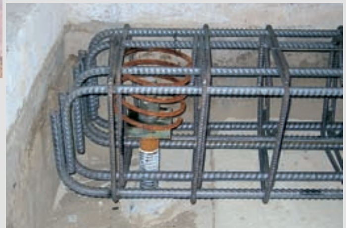
Detailansicht des GEWI® -Pfahlkopfes (Druck)
