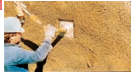
Spannen des Ankers mit dem Drehmoment- schlüssel oder der Hohlkolbenpresse
