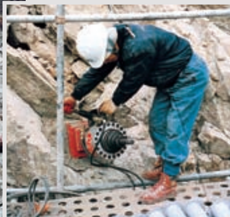
Spannen des Ankers mit DYWIDAG-Spannpresse
