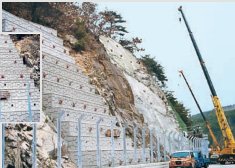
Hangsicherungsarbeiten mit DYWIDAG-Stabankern
