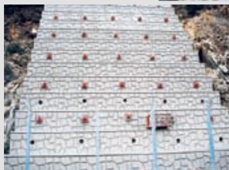
Hangsicherungsarbeiten mit DYWIDAG-Stabankern
