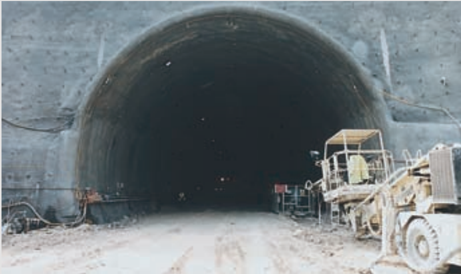
Blick auf das Tunnelportal
