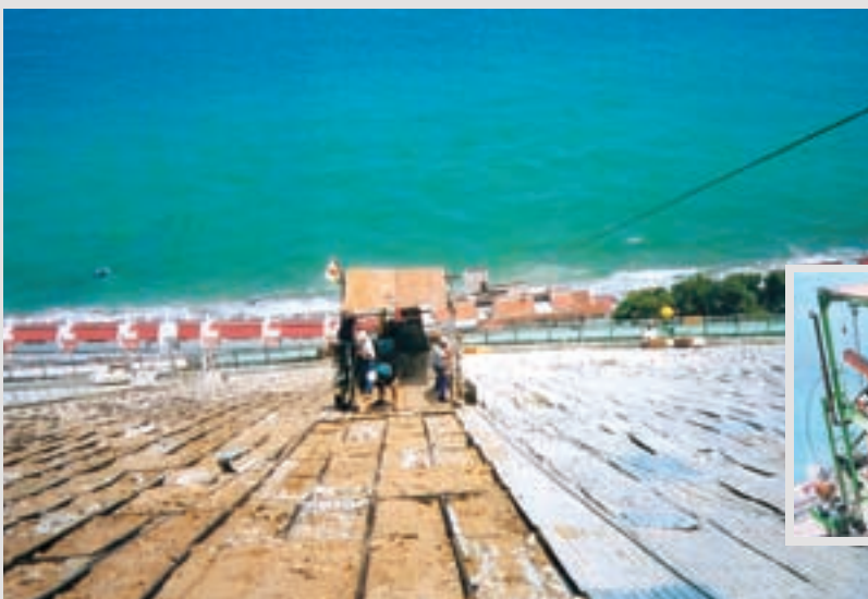
Bohrplattform im Einsatz
