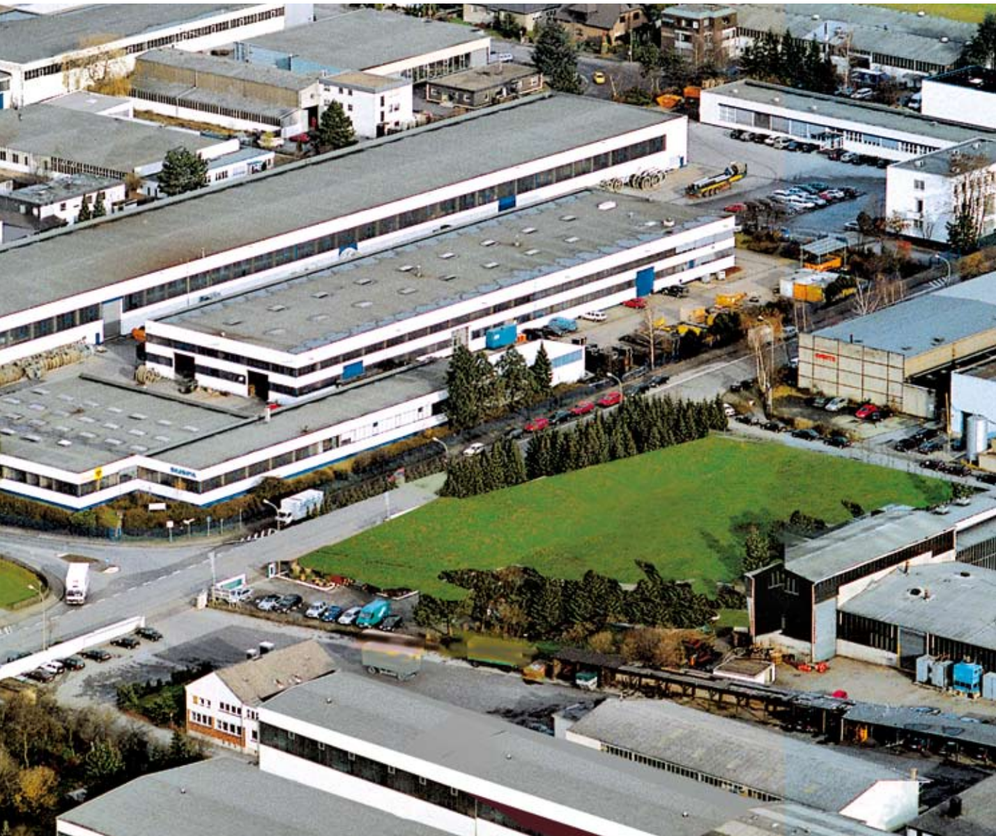
Zentrale der SUSPA-DSI GmbH, Langenfeld
