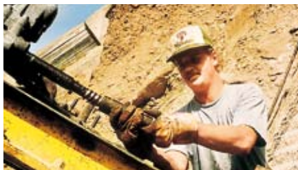
Aufschauben der Bohrkronen
