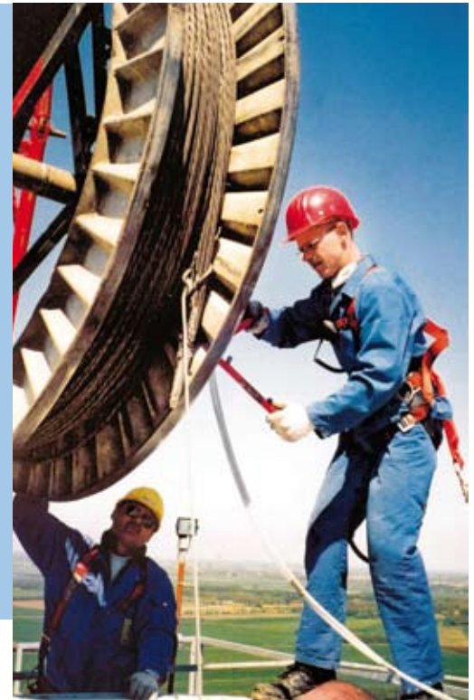
Einbau der Fertigspannglieder
