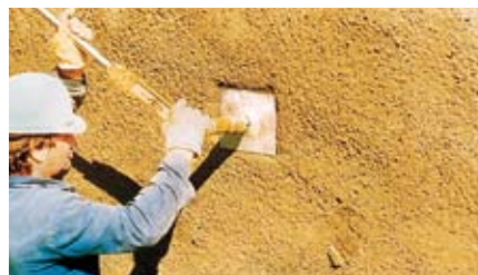
Spannen des Ankers mit dem Drehmomentschlüssel oder der Hohlkolbenpresse
