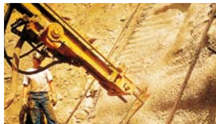
Bohren mit der Ankerstange
