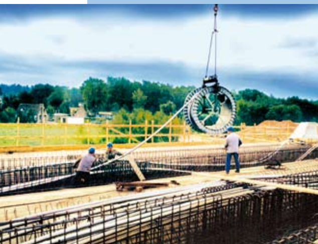
Verlegen eines Spanngliedes
