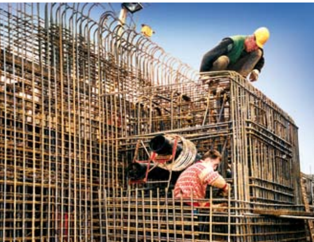
Erstellung eines Umlenkpunktes
