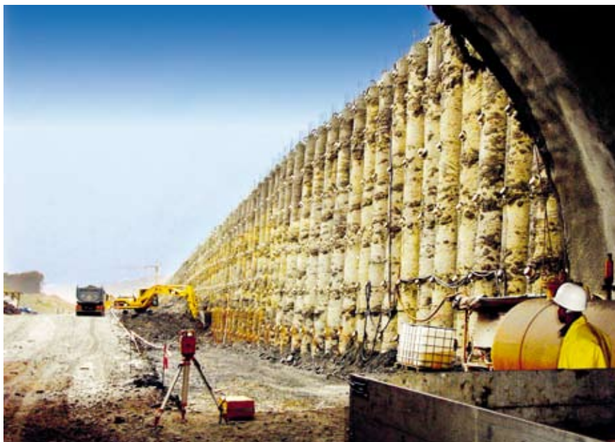
SUSPA-Kompaktanker für Fels und Boden mit Stahlzuggliedern im Bereich der Bohrpfehlwand (Tunnel Augustaburg, Nordeinstieg)
