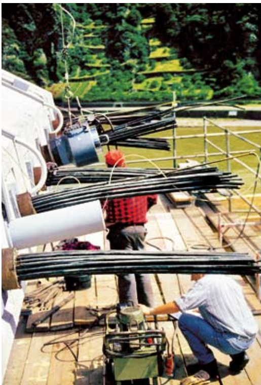
Vorspannen von Dauerankern auf 2.000 kN
