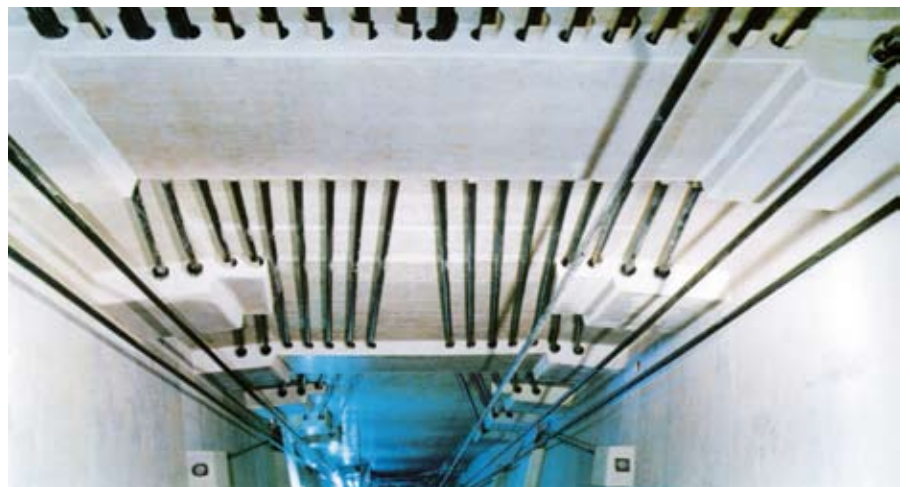
Externe Spannglieder SUSPA-Draht EX
