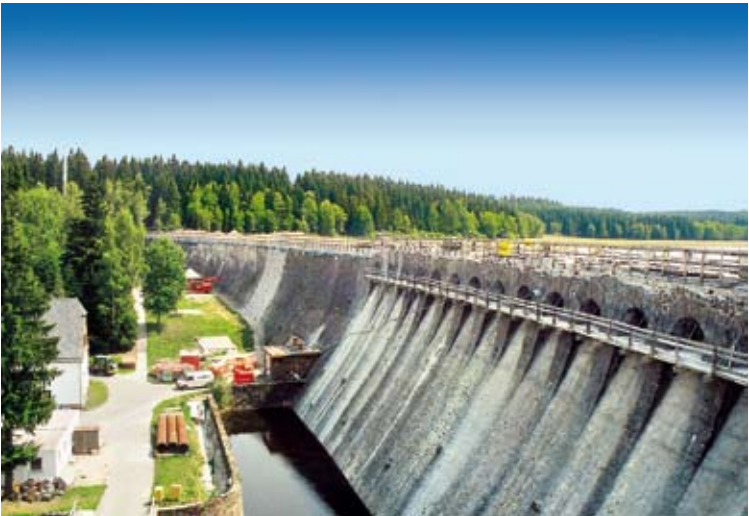
Einbau von Litzendauerankern für die Ertüchtigung einer Staumauer
