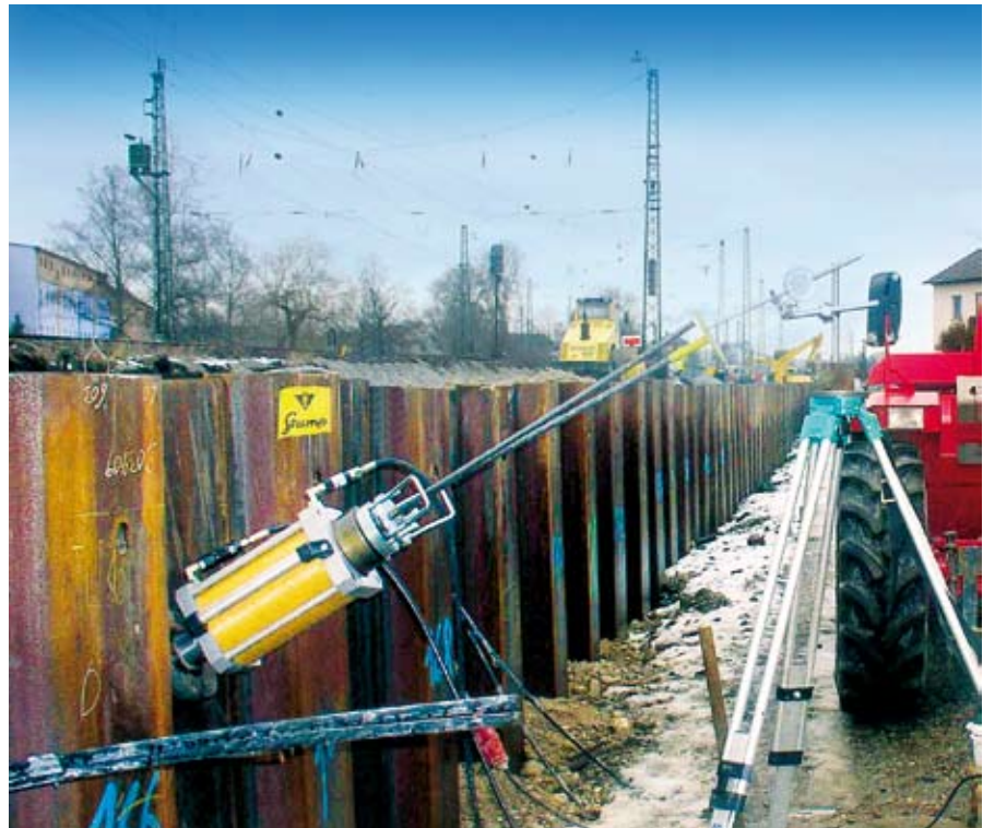
Spanneinsatz mit CFK-Hohlkolben-Zylinder 120 t zur dauerhaften Stützwand-Rückverankerung
