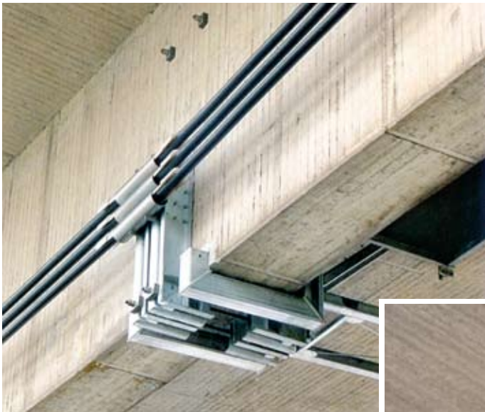
Nachträgliche Anordnung von externen Spanngliedern SUSPA-Draht EX
