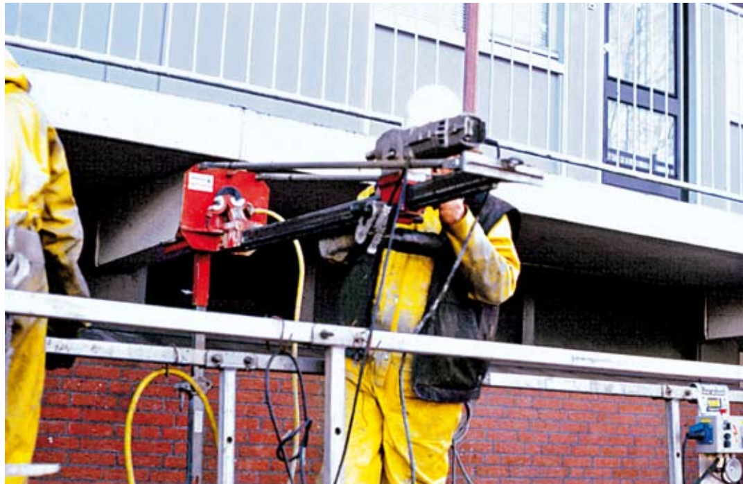
Bohrarbeiten für Titanstabanode
