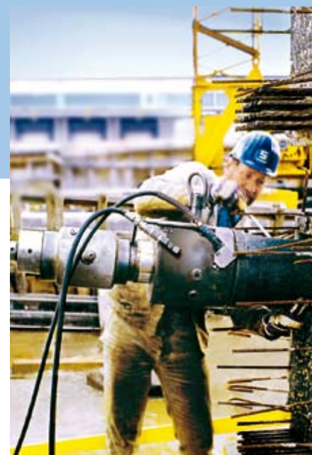
Vorspannen eines Spanngliedes
