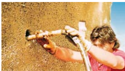
Injektion durch den Hohlstab
