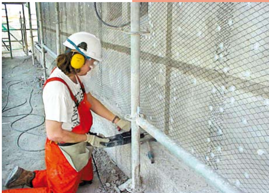
Titannetzanode mit Spritz- bzw. Aufbeton
