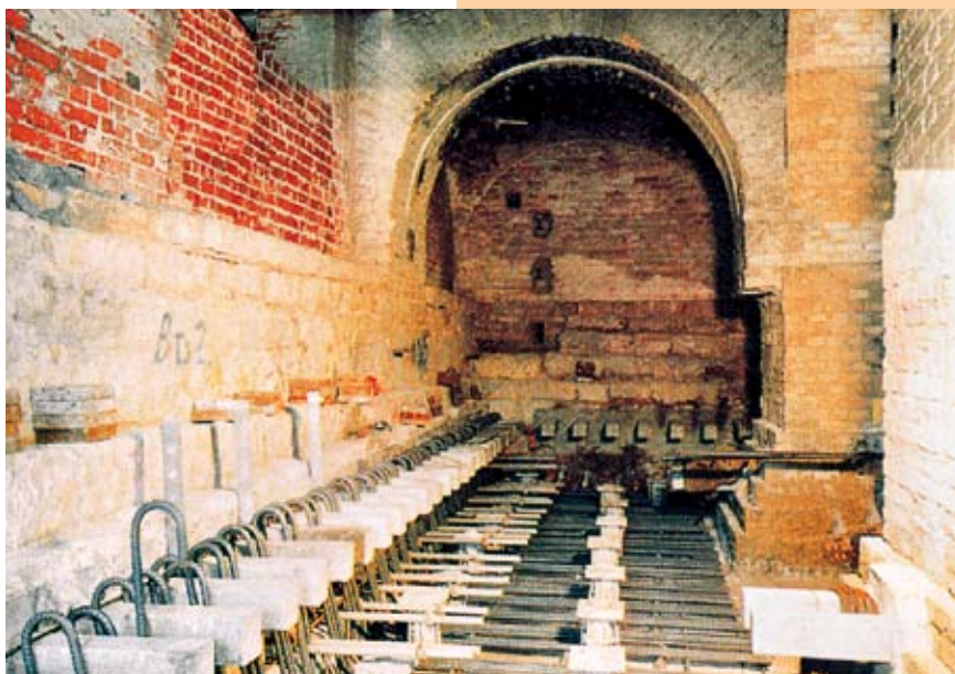
Neues Museum Berlin, Nachgründung mit Spezialpfählen
