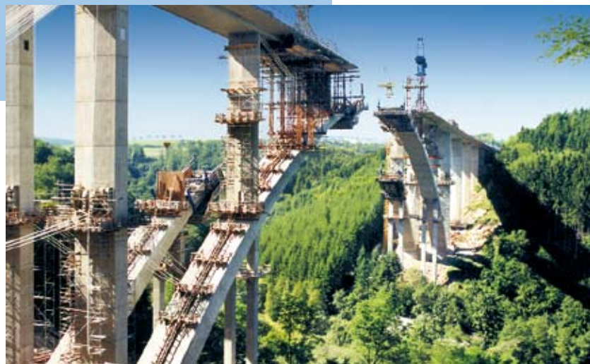
Kylltalbrücke – Verwendung von SUSPA V-Spanngliedern als temporäre Abspannung
