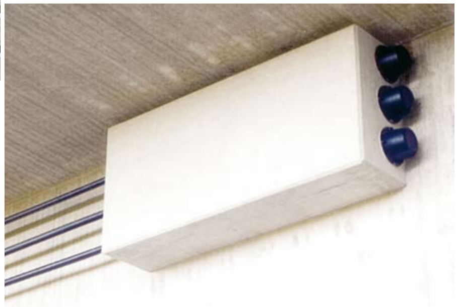
Nachträgliche Anordnung von externen Spanngliedern SUSPA-Draht EX
