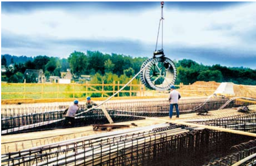
Vorzugsvariante: Einbau der SUSPA-Fertigspannglieder
