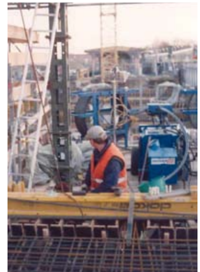
Alternativvariante: Einstoßen der Litze auf der Baustelle
