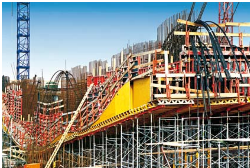
Monolitzenspannung im Hochbau
