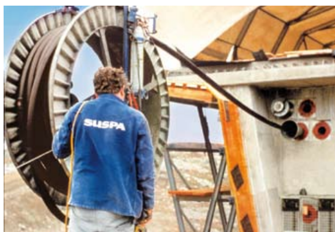
Einziehen der Spannglieder
