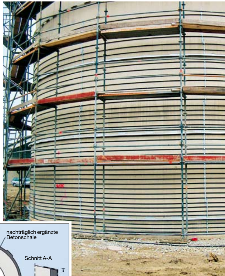
Nachträglich extern angeordnete Monolitze
