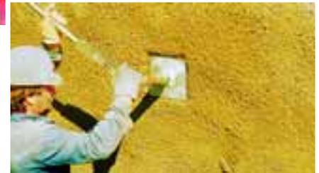
Spannen des Ankers mit dem Drehmoment-
