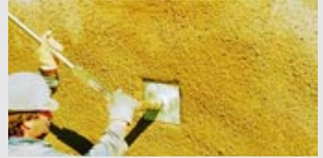
Spannen des Ankers mit dem Drehmoment-schlüssel oder der Hohlkolbenpresse
