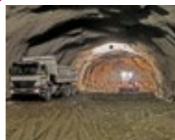
Transolímpica Tunnel, Rio de Janeiro, Brazil
